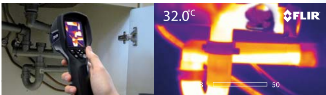
배관 내부 막힘/누수 등 각종 문제 점검
